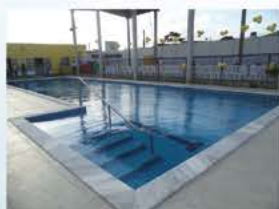
Construção da Piscina Triatleta Alvaro Vasconcelos Filho - Projeto "O Consolador"
